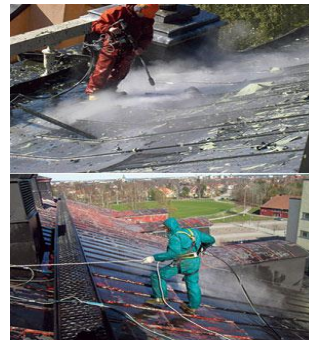
Bild 13:6. Vid tvättning ska aggregat som har ett tillräckligt arbetstryck och vattenmängd användas. Foto: Leif Johansson, Renovator
